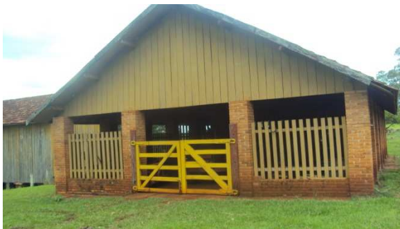
Figura 10 - Galpão da Fazenda
