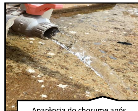
Aparência do chorume após passar pelo sistema de tratamento de efluentes líquidos;
