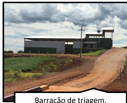
Barracão de triagem, transbordo, armazenamento e enfardamento de resíduos;
