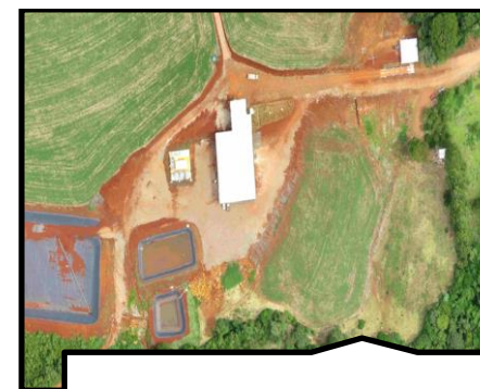
Vista superior das instalações durante a sua construção.
